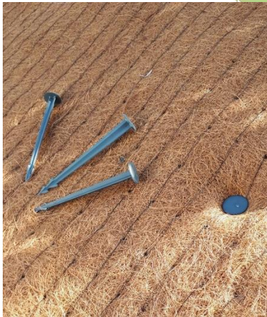
Abbildung 1: Anwendungsbeispiel Kunststoff Nagel in Kokosnetz
