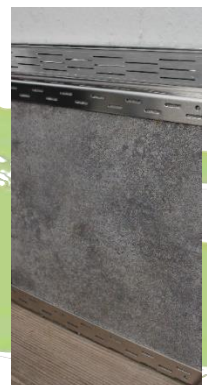
Abbildung 3: Einklicktes Drainrost zum Verdecken der Schraubenköpfe
