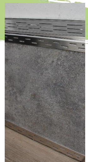
Abbildung 3: Einklicktes Drainrost zum Verdecken der Schraubenköpfe
