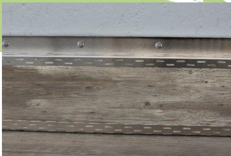
Abbildung 2: Sockelverblendung optisch an vorhandenen Bodenbelag angepasst
