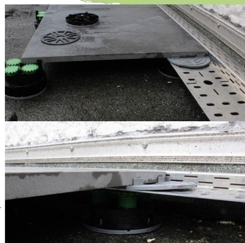
Abbildung 4: VP-GKUI aufgelegt auf Drainprofil WD-Z
