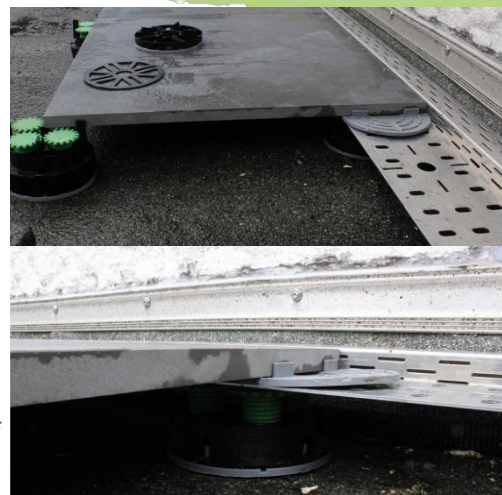
Abbildung 4: VP-GKUI aufgelegt auf Drainprofil WD-Z
