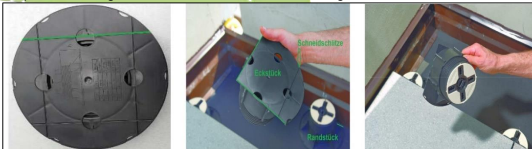
Abbildung 8: Verlegung im Rand- und Eckbereich. Vorgefertigte Schneidschlitzte im Unterteller ermöglichen einfache Anpassung des Stetzlagers
