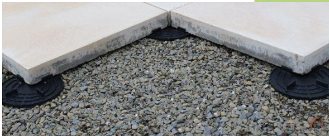
Abbildung 2: Beispielverlegung im Kiesbett. Verwendet wird: VP-U 4/10. Durch den 140mm Durchmesser wird das Gewicht der Platten großflächig verteilt.
