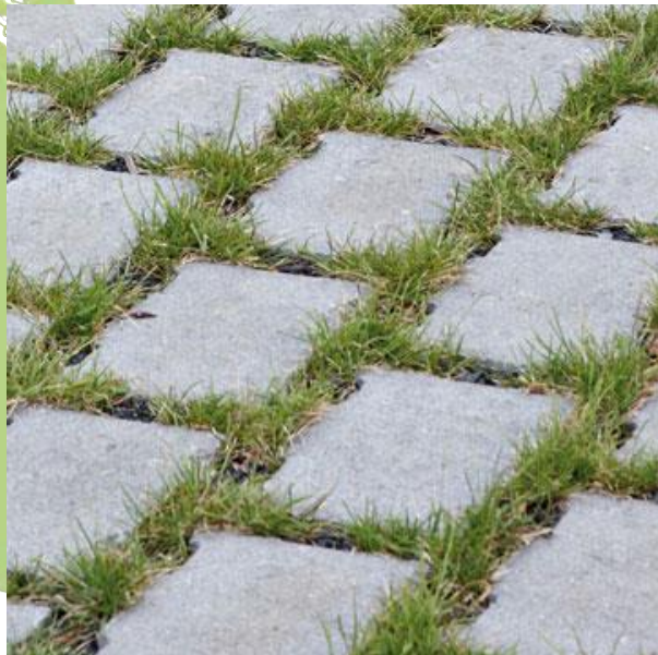
Abbildung 4: Beispiel Verlegte Fläche
