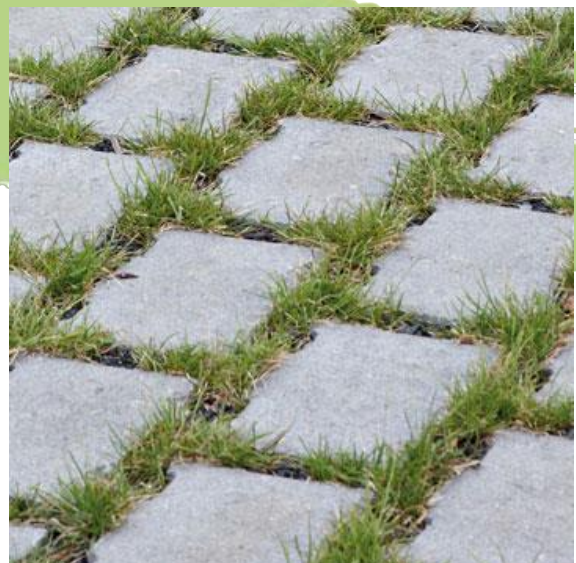
Abbildung 3: Beispiel Verlegte Fläche
